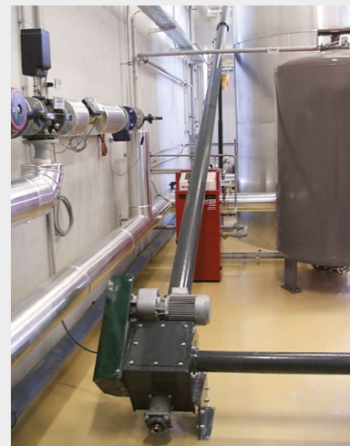
Ilustracja: System odprowadzania popiołu za pomocą ślimaka wznoszącego na wysokość 4m do kontenera o objętości 2 m 3 znajdującego się poza pomieszczeniem kotłowni.
